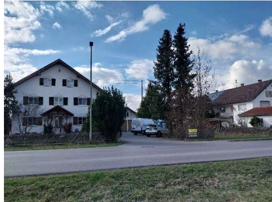
Abbildung 4: Umgebungsbebauung: Wohnhaus Buchloerstraße 3
